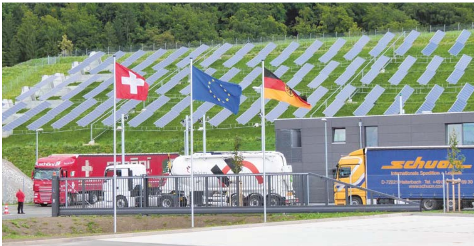
Flüssiger als am ersten Tag lief gestern der Betrieb auf der neuen deutsch-schweizerischen Gemeinschaftszollanlage für Lastwagen in Waldshut.
